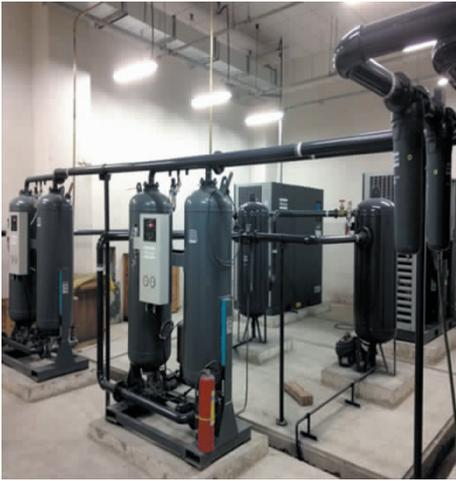
图 5 医用空气压缩机系统供应源
